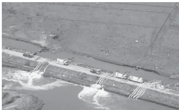
写真一 2 ポンプ車による排水状況
