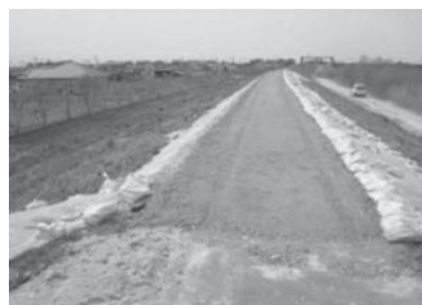
写真一九 復旧状況【江合川（宮城県美里町）】
