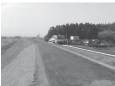
写真一八 復旧状況【阿武隈川下流（宮城県角田市）】
