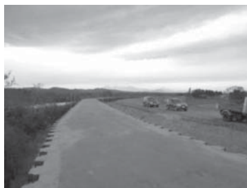
写真一五 阿武隈川下流（宮城県角田市）の被災状況と鋼矢板二重締切による復旧状況
