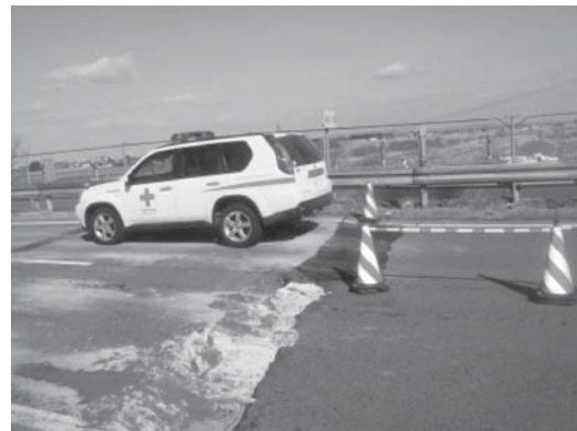
写真一7 アスファルト合材による緊急復旧状況
