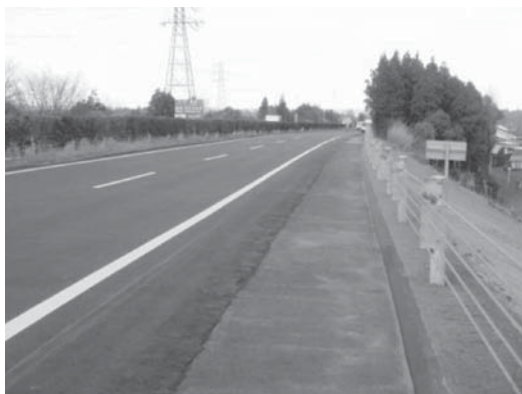
写真一9 応急復旧の完了 (3月17日午後5時頃)
