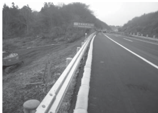
写真一11 応急復旧の完了 (4月10日午前6時頃)
