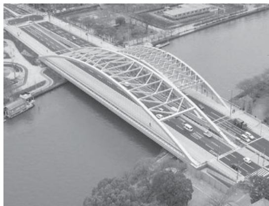
写真—2 完成した新桜宮橋と桜宮橋
