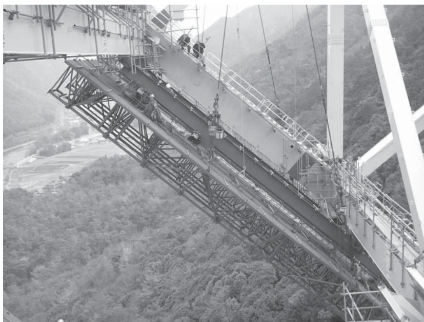
写真一 移動防護工 設置状況
