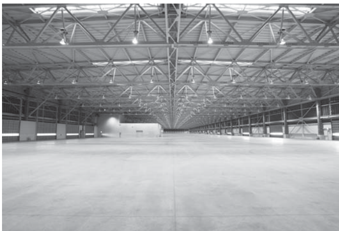
写真一 2 上屋無柱空間
