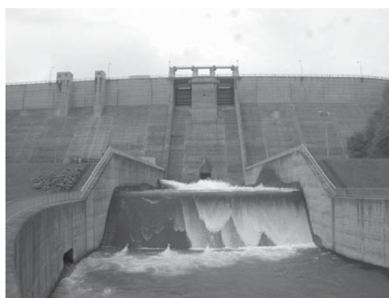
写真一3 堤体下流面(昭和58年完成)
