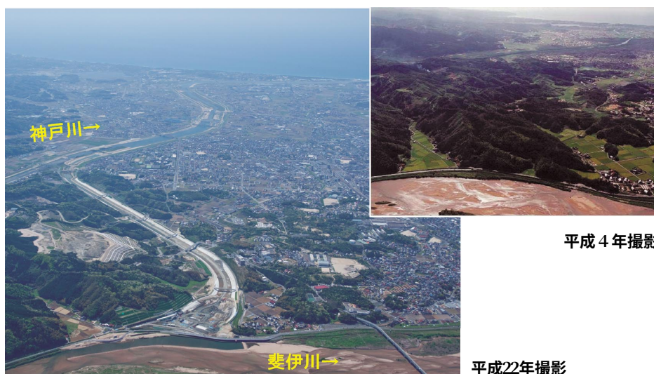
写真-4 工事着手前と現在の斐伊川放水路分流部付近から放水路を望む
