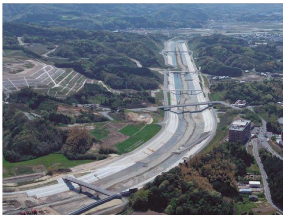
写真－7 掘削した開削部の状況 開削部の左側は残土処理場
