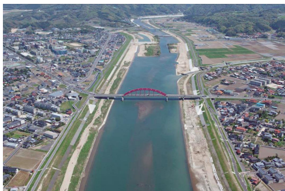
写真-5 広がった拡幅部の状況
