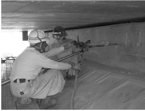
写真－3 削岩機による削孔
