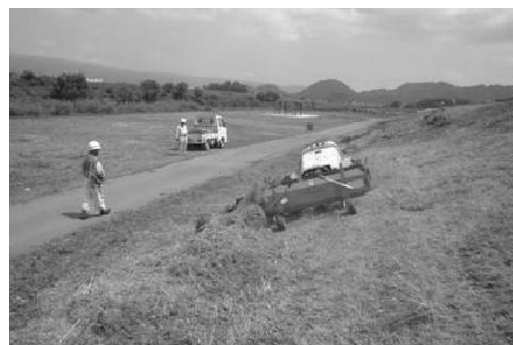
写真-2 遠隔操縦草刈機による集草
