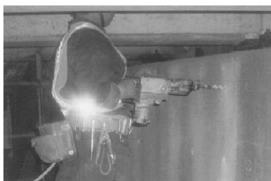
写真ー１ ハンマドリルによる削孔
