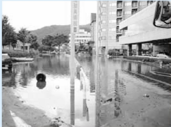
7/20 昼頃の冠水状況（諏訪市湖岸通り2丁目付近）
