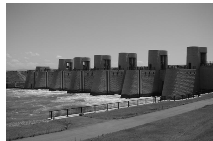
写真 6 平成12年通水した新洗堰
