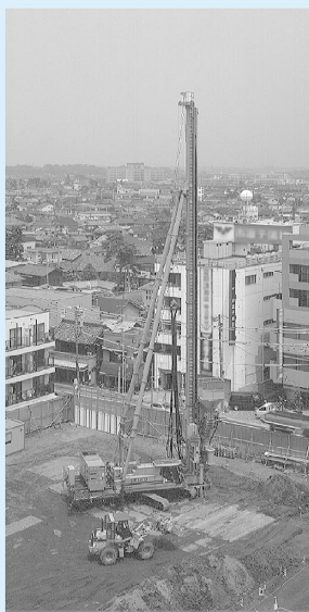
写真 1 市街地での近接施工
