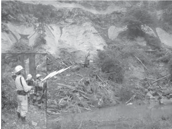
写真 4 無人化施工イメージ
