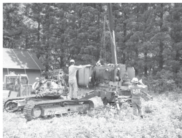
写真 2 油圧ショベル組立の状況
