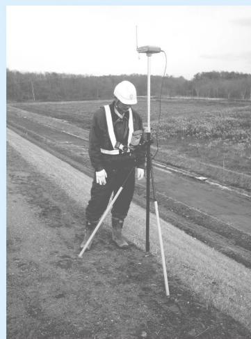
写真 1 RTK-GNSSを用いた出来形計測
