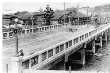
写真 2 短命に終わった鉄筋コンクリート橋の犀川大橋
