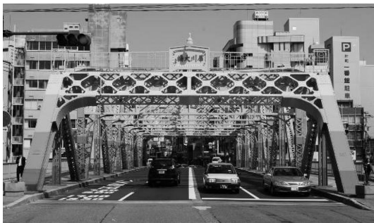
写真 4 補修工事が完了した犀川大橋 金沢箔で装飾した橋名板がアクセントとなっている
