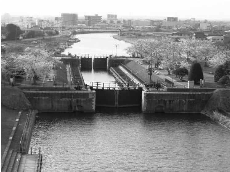
写真 1 横利根閘門全景（利根川側より望む）
