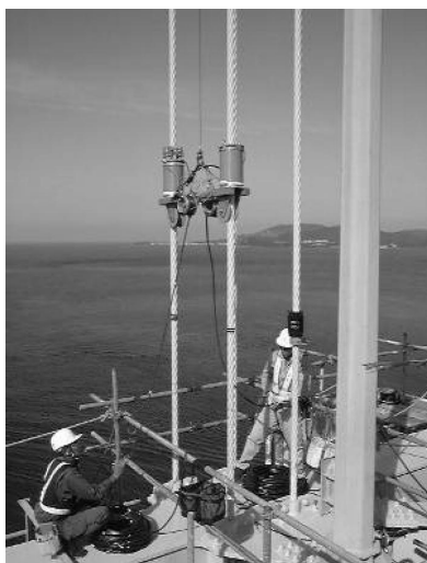
写真 1 全磁束法による非破壊検査
