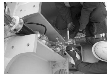
写真 3 ハンガーロープ内部充填工法
