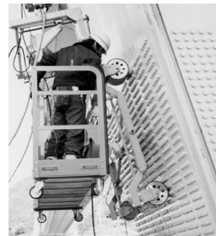
写真 4 磁石車輪ゴンドラ
