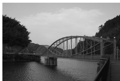
写真 4 現在の南河内橋
