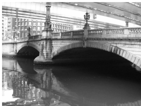
写真 2 現在の日本橋（右岸上流側から平成20年撮影）
