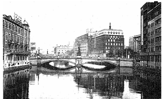
写真 1 竣工当時の日本橋（上流側から撮影）
