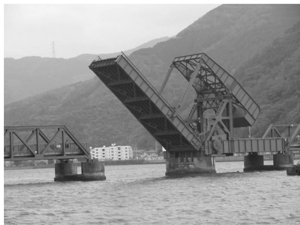
写真 1 跳ね上げた状態の長浜大橋
