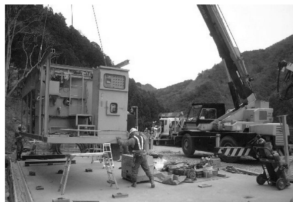
写真 2 設備の設置作業
