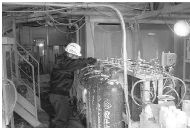
写真 4 保守点検（ポンベの交換・調整）
