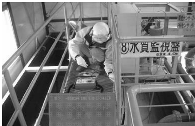
写真 3 保守点検（水質の確認作業）
