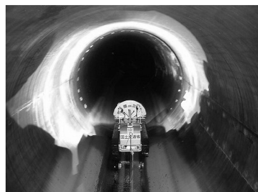
写真-10 管内調査
