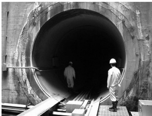
写真－11 導水路の入口
