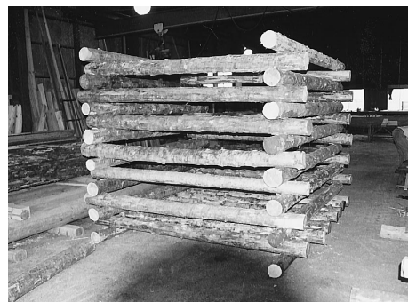
写真－２ 工場での仮組立て
