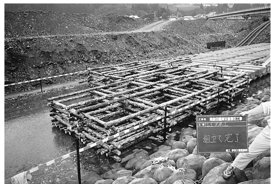
写真－４ 組立て完了
