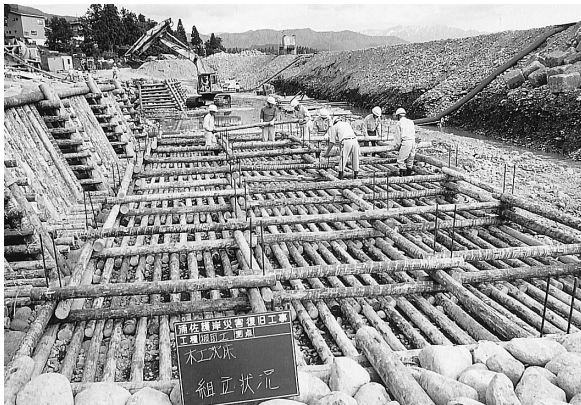
写真－１ 木工沈床の施工（従来工法）
