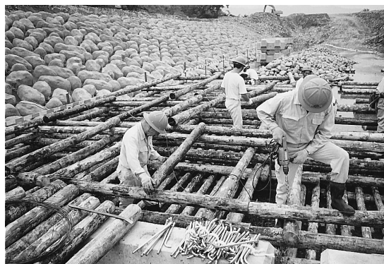
写真－３ アンカーボルトによる部材の接続
