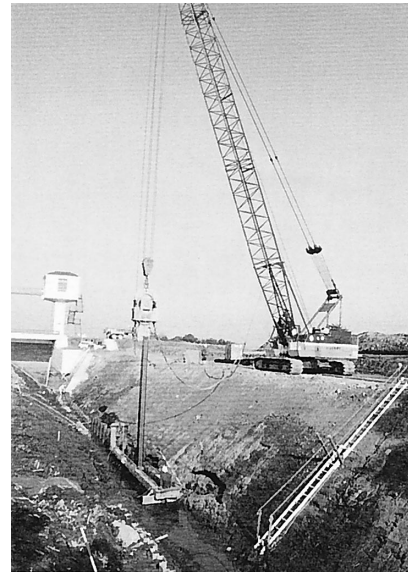
写真 - 3 パイプロハンマ工（広幅鋼矢板）
