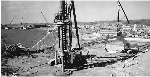
写真 2 スラリー攪拌工（単軸施工）
