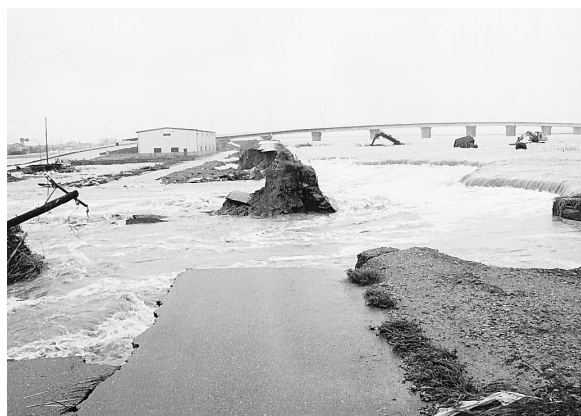
写真 1 熊本県 氷川（台風18号による破堤状況）
