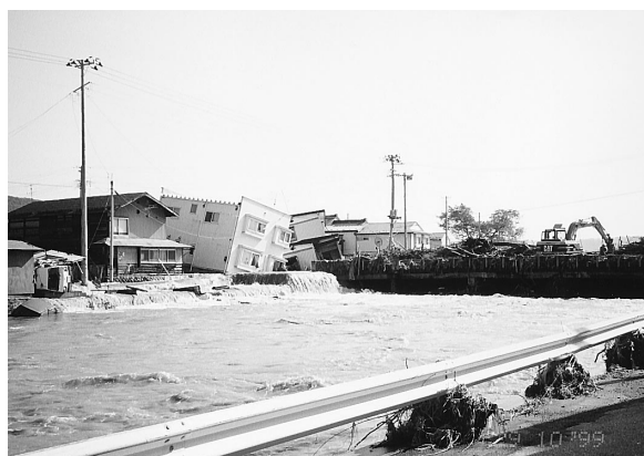
写真 2 岩手県 雪谷川（10月27日からの大雨による被災状況）
