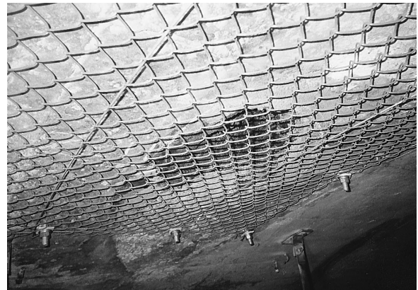
写真 2 覆工亀裂の著しい箇所は落下防止ネットで防護してから工事を実施
