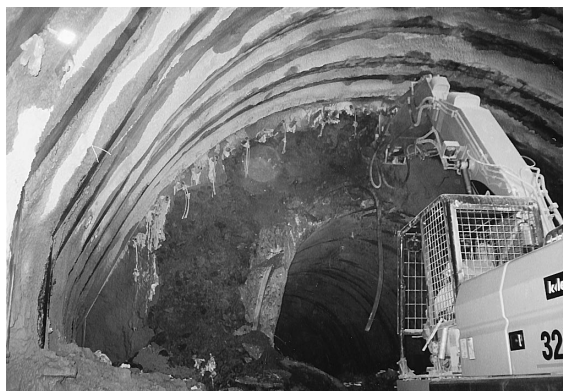
写真 6 AGF 施工状況
