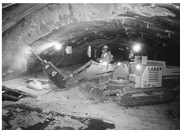
写真 3 油圧ブレイカーでの覆工取壊し状況
