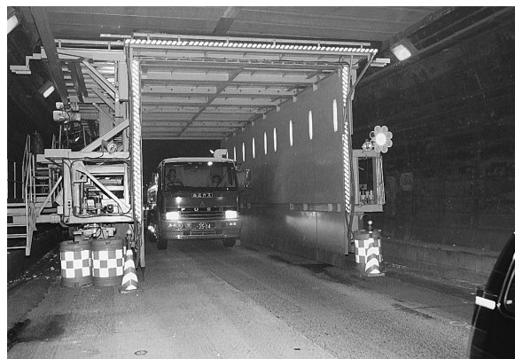
写真 4 交通を確保するために採用したプロテクター
