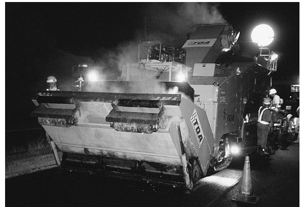
写真 1 2 種混合物同時敷均工法
