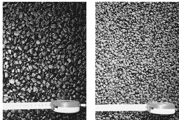
舗装の表面 第一走行車線 13 ~ 8 mm 舗装の表面 追越車線 8 ~ 5 mm
