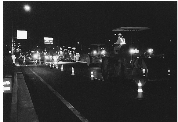
乳剤散布装置付きアスファルトフィニッシャー 2台によるホットジョイント施工(夜間)
