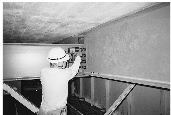
写真－５ ボルト締め状況（増桁架設工法）
