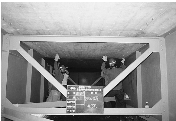
写真－２ 鋼板設置状況（鋼板接着工法）
