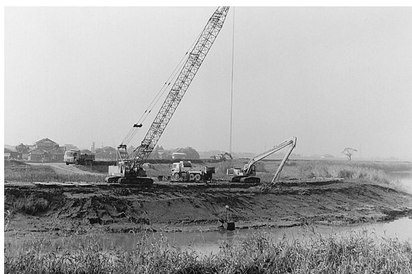
写真－１ ロープ式クラムシェルによる水中掘削状況
