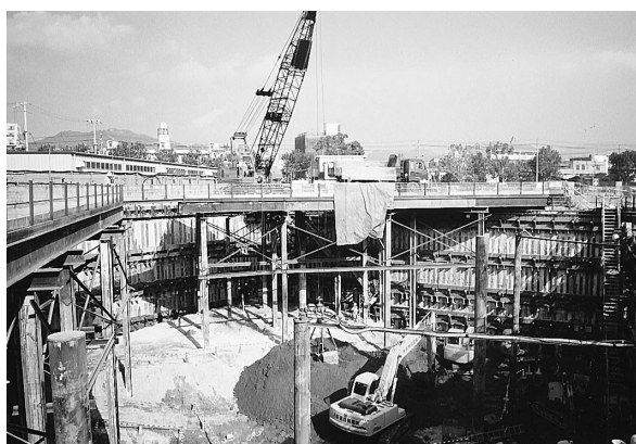
写真－２ ロープ式クラムシェル+小型バックホウによる掘削状況
