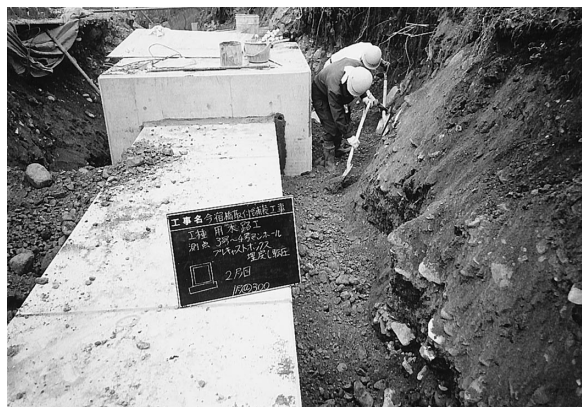
写真-3 埋戻し状況
