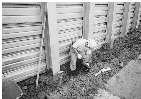
写真-3 埋戻し状況
