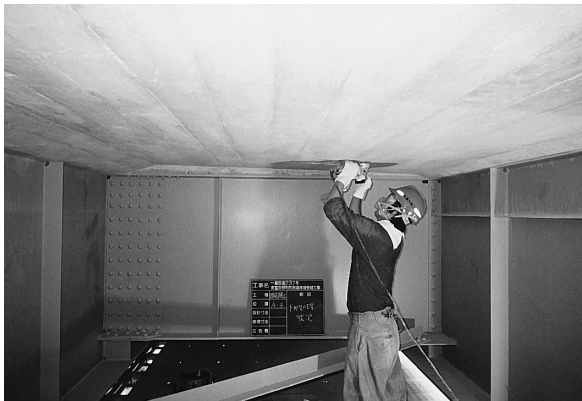
写真－１ 下地処理状況（鋼板接着工法）
