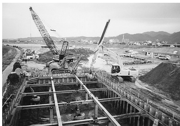
写真－３ テレスコピック式クラムシェル+小型バックホウによる掘削状況
