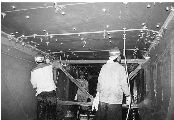
写真－３ 注入状況（鋼板接着工法）
