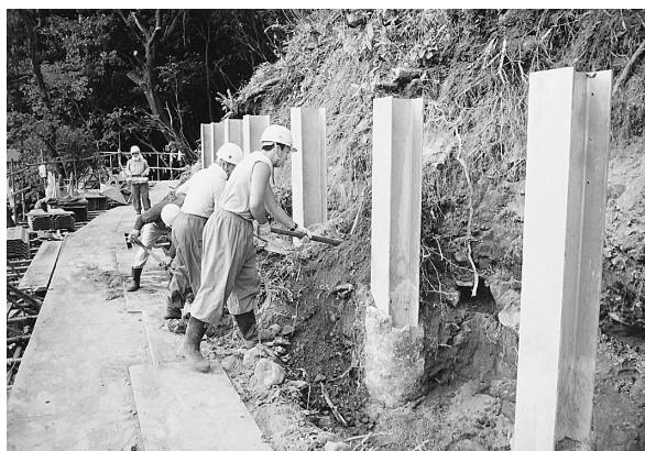
写真-1 切崩し状況
