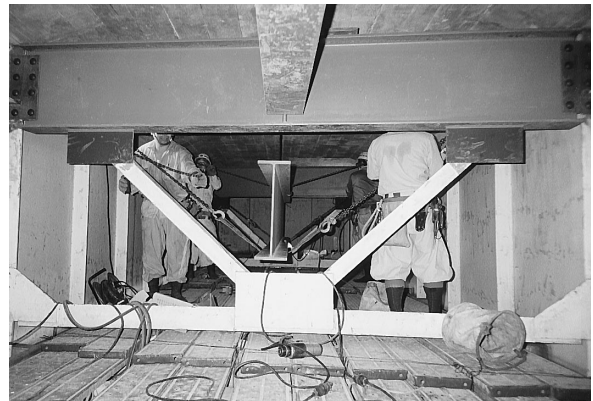
写真－４ 増桁取付状況（増桁架設工法）
