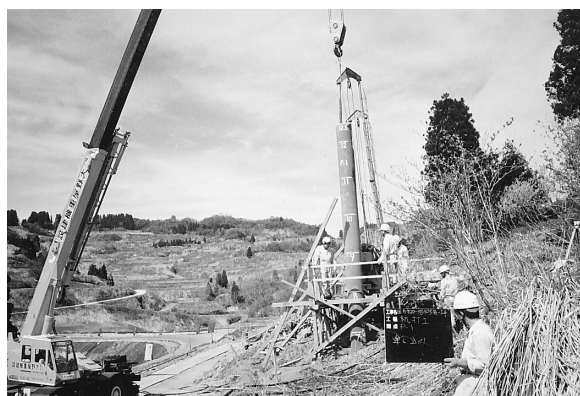
写真－６ 鋼管杭建込み状況（移動式クレーン）
