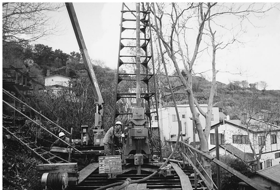
写真-1 大口径ボーリングマシンによる施工状況
