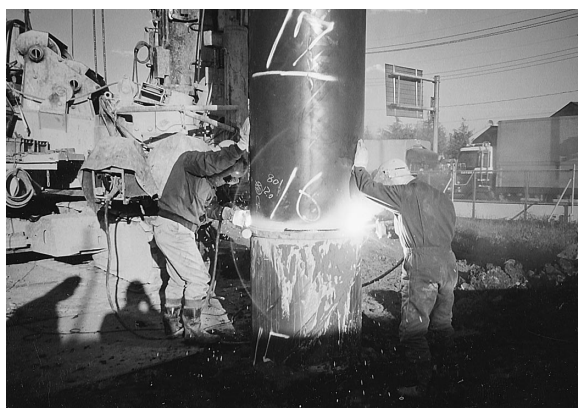
写真－3 継杭状況（鋼管杭）
