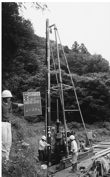
写真－５ 鋼管杭建込み状況（ウィンチ）
