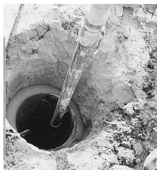
写真－７ モルタル注入状況（鋼管杭）
