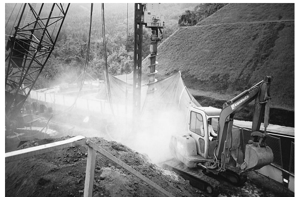
写真-4 削孔状況
