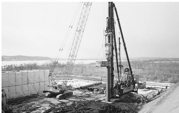
写真－1 鋼管杭掘削状況
