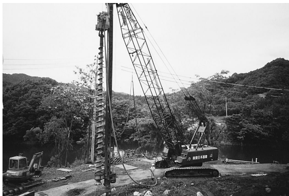
写真-2 移動式クレーンとリーダによる施工状況
