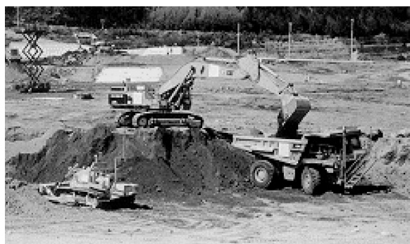
写真－1 無人化機械による作業状況
