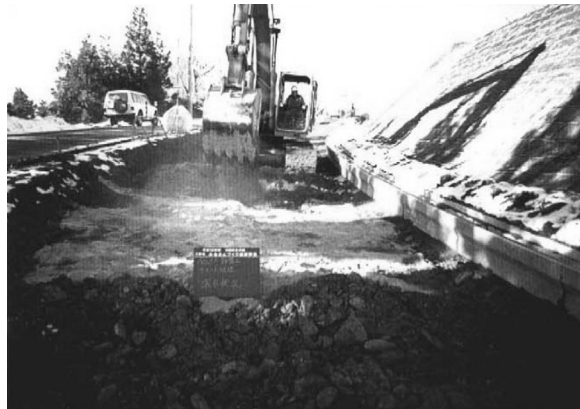
写真 7 バックホウによる混合状況
