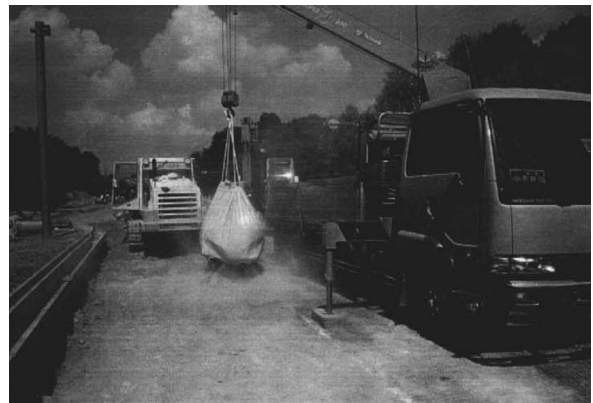
写真 2 トラッククレーンによる固化材散布状況
