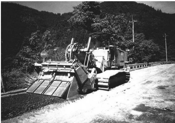
写真 3 スタビライザによる混合状況
