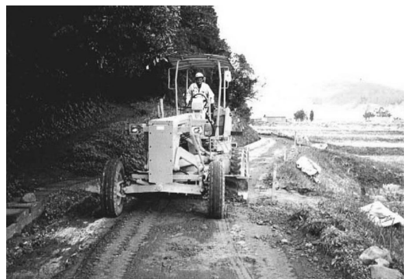
写真 4 モータグレーダによる敷均し状況
