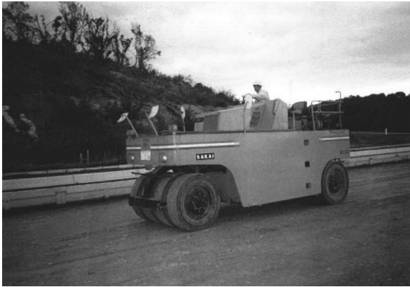
写真 5 タイヤローラによる締固め状況
