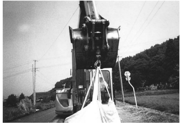
写真 6 バックホウによる固化材散布状況
