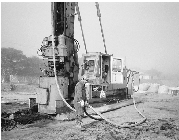
写真 2 粉体噴射攪拌機(二軸式)
