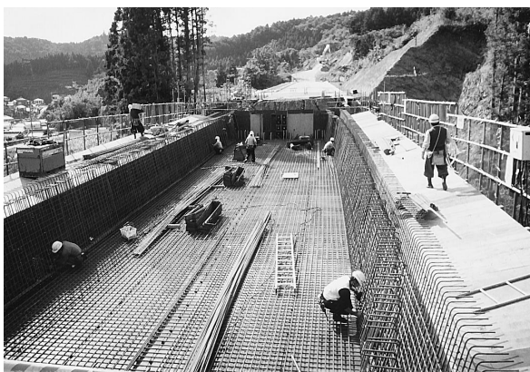
写真－1 鉄筋組立
