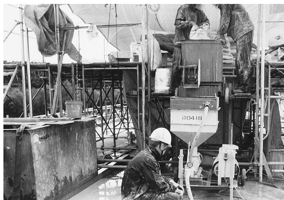
写真－5 シース内グラウト
