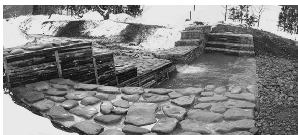
大川床固工群（北陸地方整備局）における床固工
