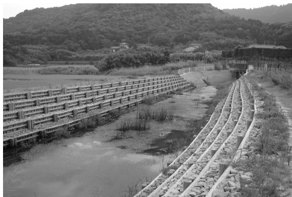
宮里川（鹿児島県）における護岸工
