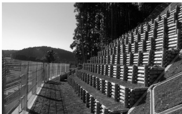
内ノ迫地区急傾斜崩壊対策事業による土留柵工
