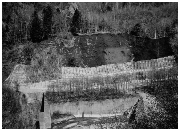
蒲田川（北陸地方整備局）における山腹工
