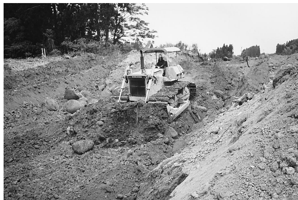
写真－2 掘削押土②
