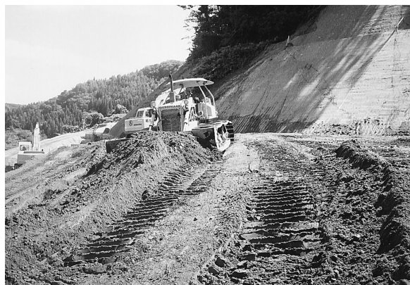
写真－3 掘削押土敷均し
