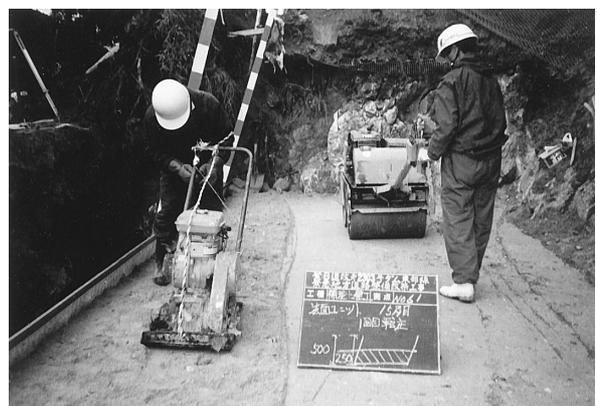
写真 8 締固め状況
