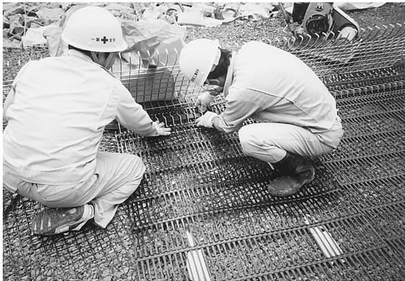
写真 2 壁面材（鋼製ユニット）の設置状況
