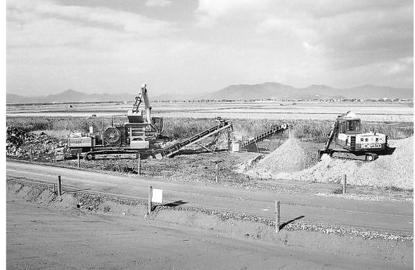
写真 1 骨材再生工（全景）
