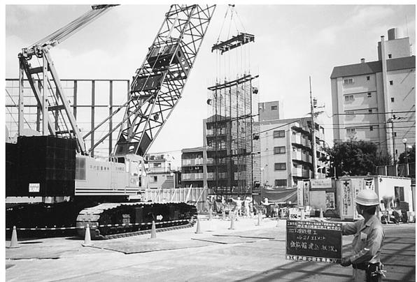
写真 2 鉄筋かごの建込み状況
