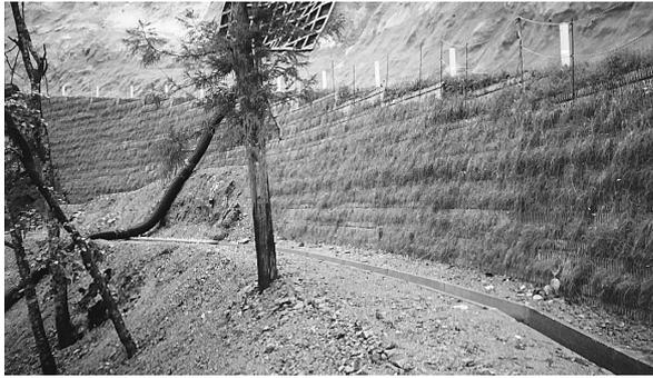
写真 1 鋼製枠形式の全景
