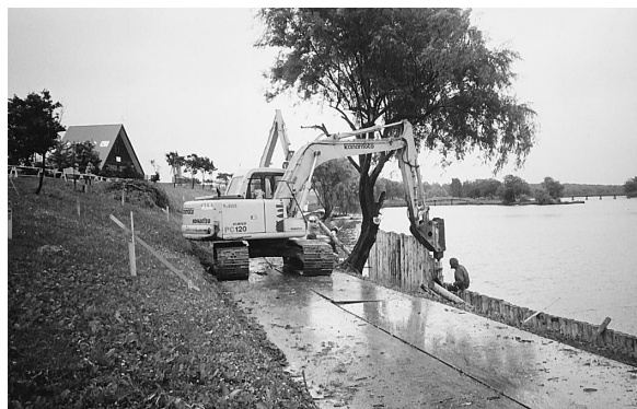
写真－１ 作業状況(1)
