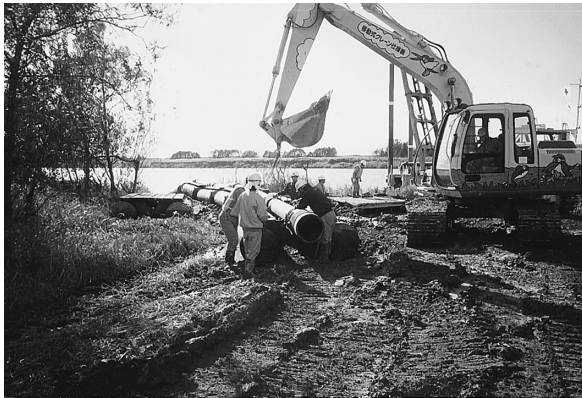
写真－５ バックホウ（クレーン機能付）による排砂管設置状況
