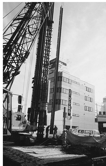
写真－３ 芯材建て込み作業
