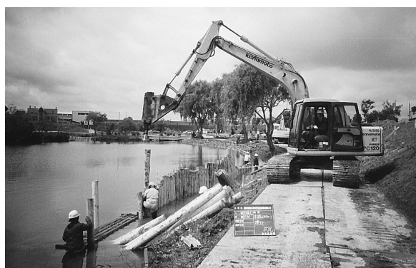
写真－２ 作業状況(2)
