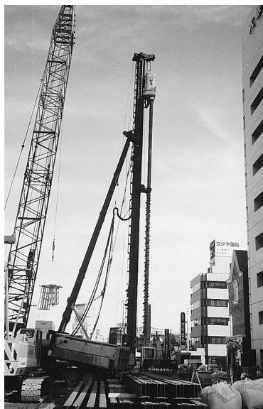
写真－１ 施工全景
