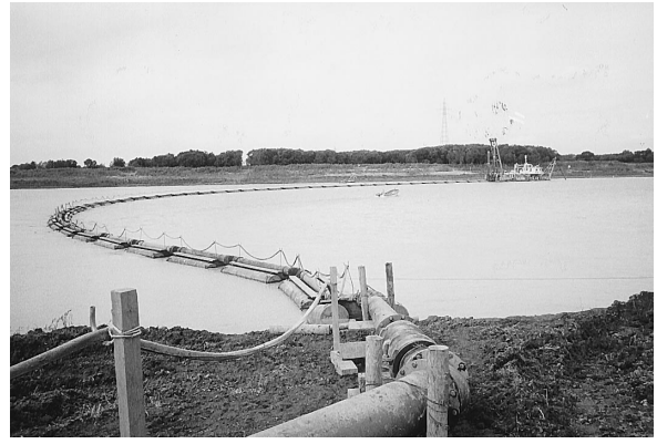
写真－６ 排砂管設置完了
