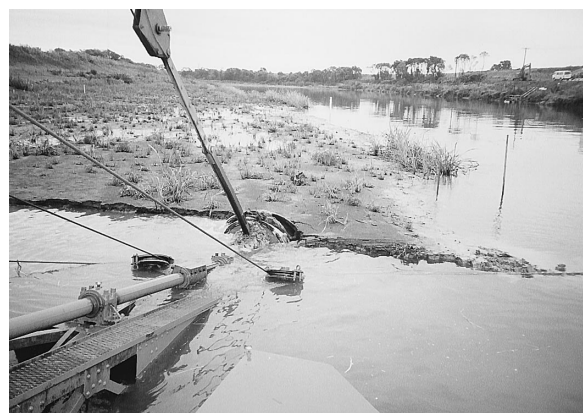
写真一2 浚渫作業（カッタ）
