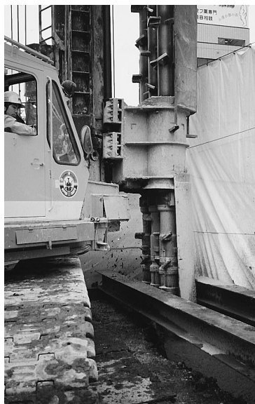
写真－２ 掘削混練作業
