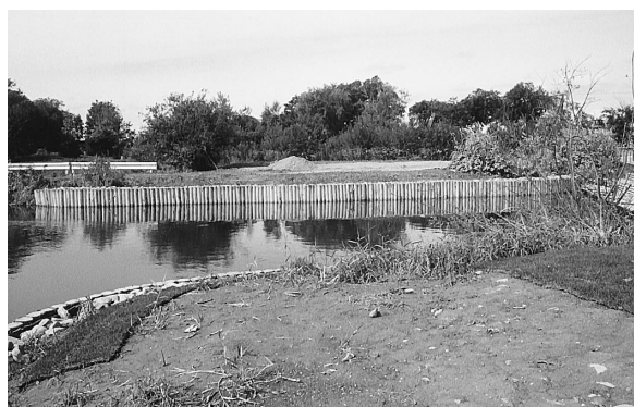
写真－３ 作業完了
