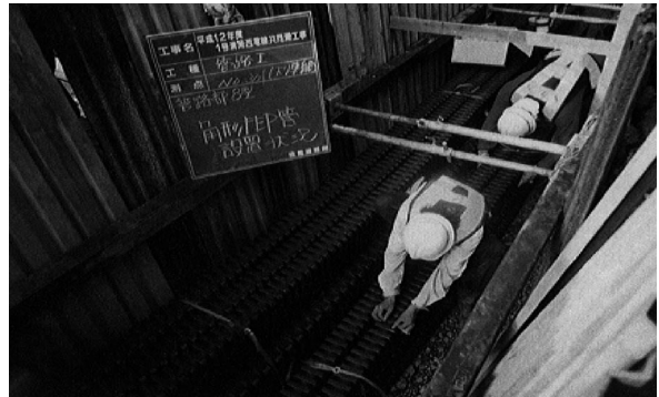
写真 1 管路部設置作業状況
