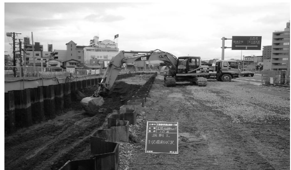
写真 1 バックホウ掘削作業状況
