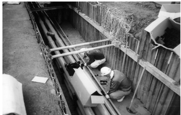
写真 2 管路部設置作業状況
