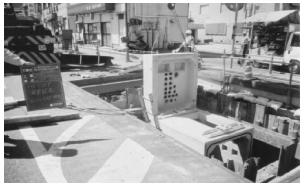
写真 3 特殊部設置作業状況
