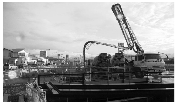
写真 3 コンクリートポンプ車打設作業状況
