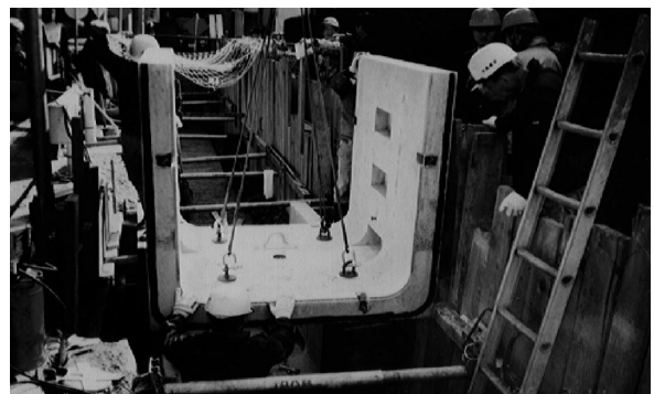
写真 4 特殊部設置作業状況
