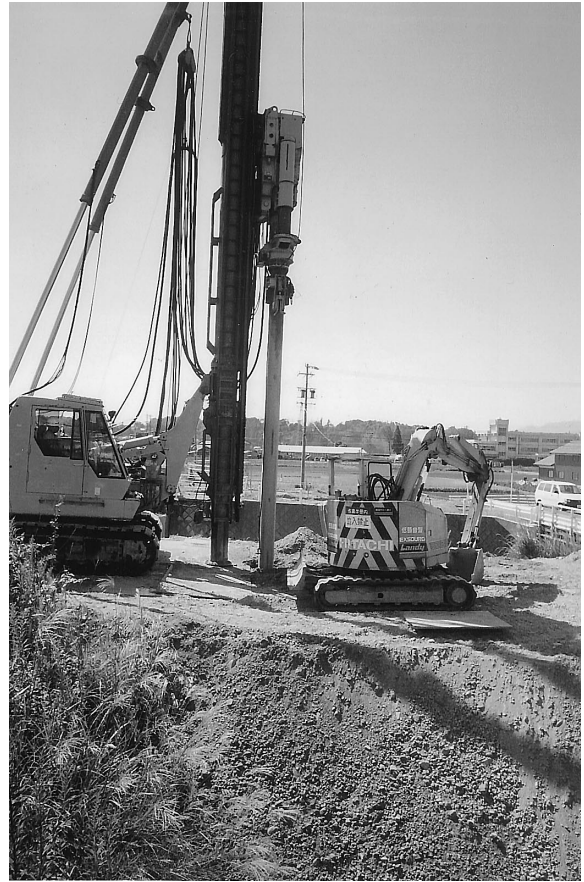
写真 1 矢板吊込状況（左上） 写真 2 矢板圧入状況（左下） 写真 3 オーガ引抜き状況（右）
