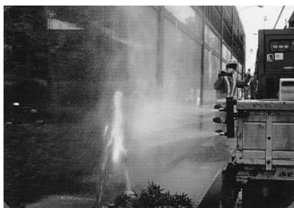
写真－2 現地システム試験の状況
