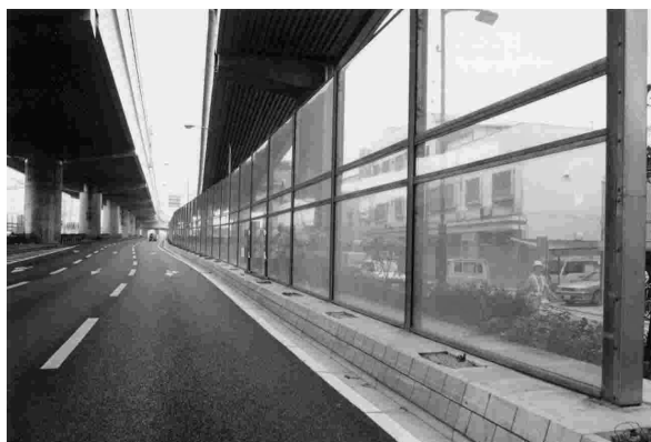
写真－1 透光性遮音壁設置状況
