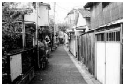
写真-1 災害時に危険な木造住宅密集市街地：板橋区大山
