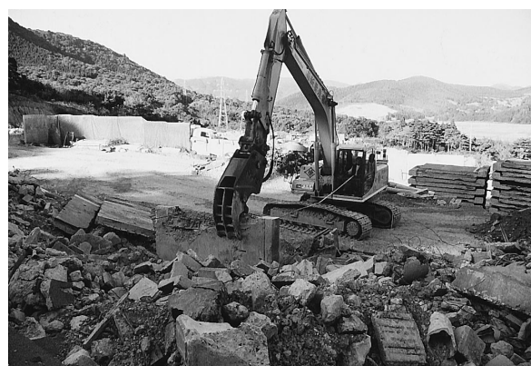
写真-3 二次破碎状況
