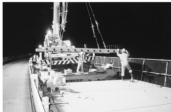
写真-4 プレキャスト床版架設状況
