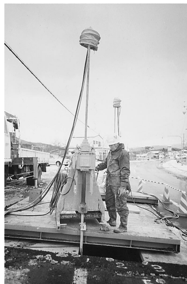
写真-3 注入状況
