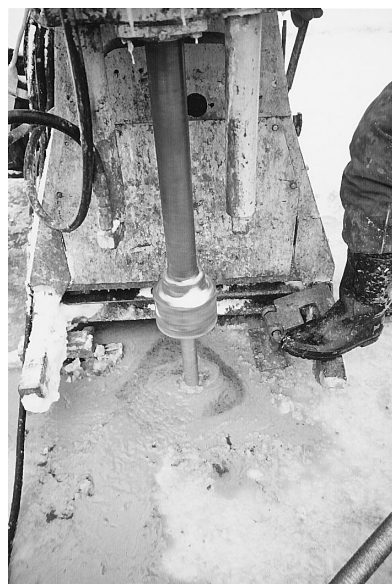
写真-2 削孔状況(2)
