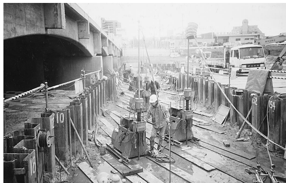
写真-1 削孔状況(1)
