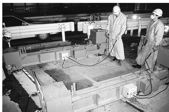
写真-2 油圧ジャッキによる床版撤去
