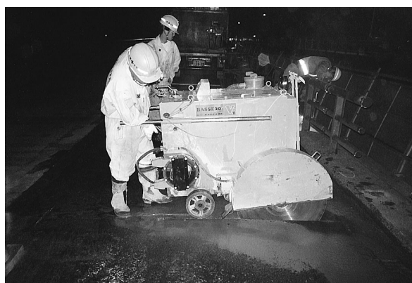
写真-1 既設床版切断状況
