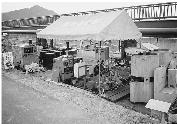
写真-4 注入機械
