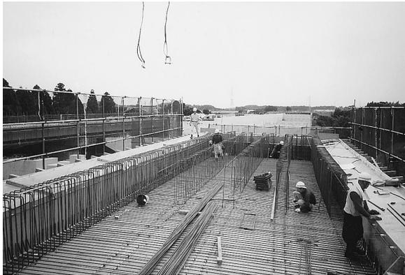
写真 1 鉄筋組立・加工
