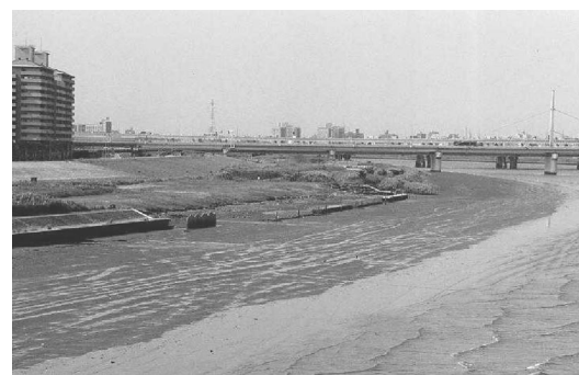
▲直立護岸の地上部を撤去した実証試験箇所（東京都江戸川区）
