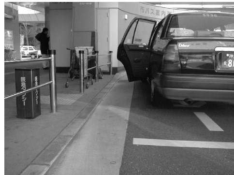
タクシー停車位置に接する部分を切り下げ、乗降しやすくする
