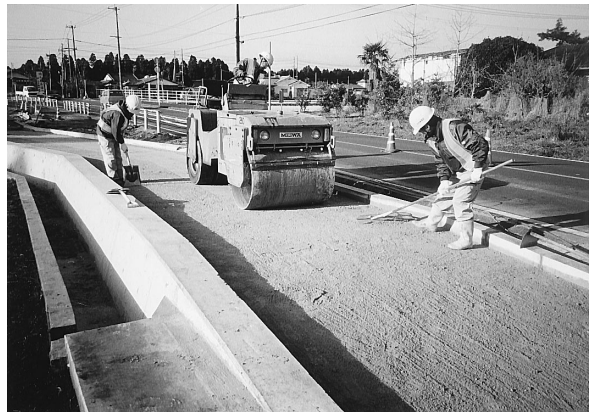
写真 1 振動ローラ(コンパインド型)施工状況
