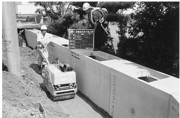
写真 2 振動ローラ(ハンドガイド式)施工状況
