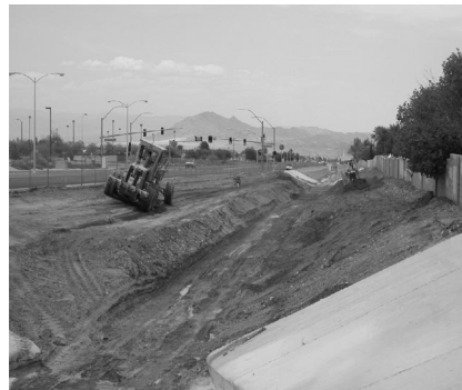
写真 3 河川土工作業
