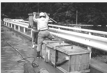
写真 5 局部プレスト工
