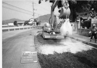
写真 2 固化材散布状況
