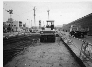
写真 5 締固め状況
