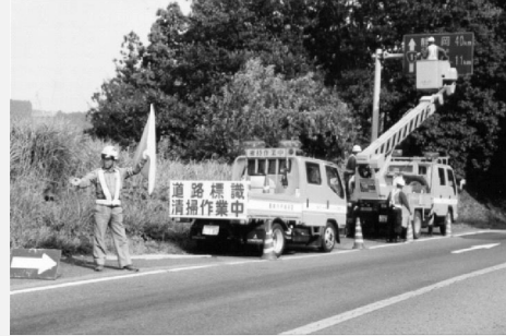
写真 2 清掃状況（片持式）
