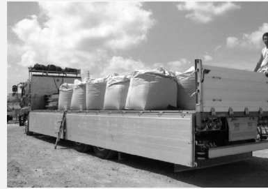
写真 1 固化材搬入状況
