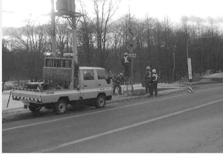
写真 1 清掃状況（路側式）
