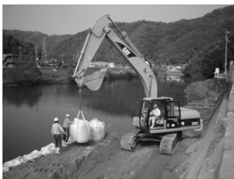
写真 2 バックホウ(クレーン仕様)による据付状況
