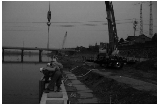
写真 6 型枠撤去状況
