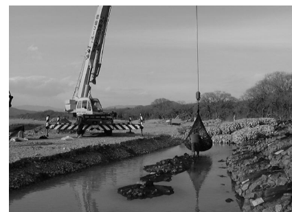
写真 3 ホイールクレーンによる据付状況
