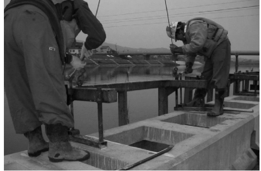
写真 4 型枠設置状況
