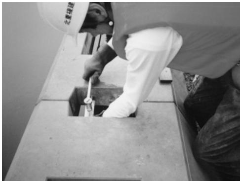
写真 3 ブロック連結状況
