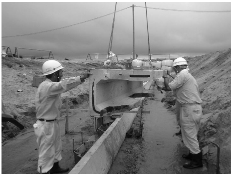
写真 2 笠コンクリートブロック据付状況
