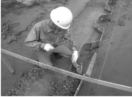
写真 1 高さ調整金具取付状況
