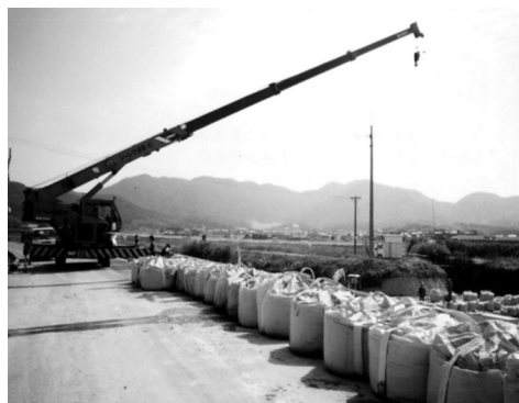
写真 3 ホイールクレーンによる据付状況
