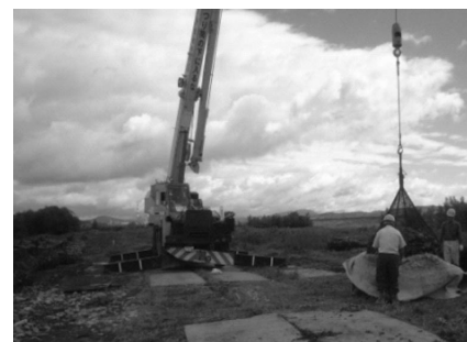
写真 2 ホイールクレーンによる横移動・仮置状況
