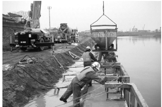
写真 5 中詰コンクリート打設状況
