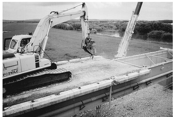
写真 3 床版一次破碎・撤去作業
