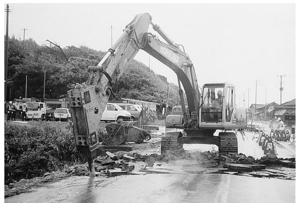
写真 2 舗装版破碎作業
