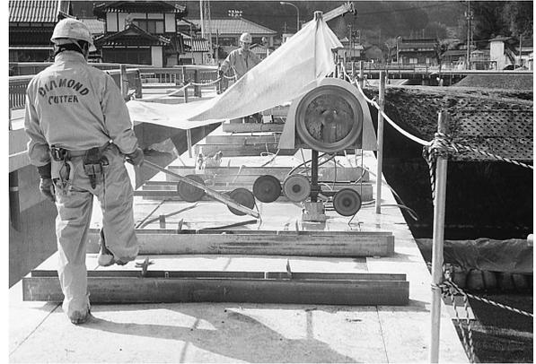
写真 5 ワイヤソー工法による床版切断作業
