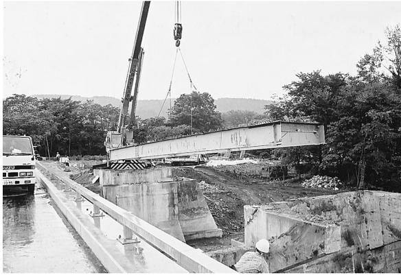
写真 4 桁一次切断・撤去作業
